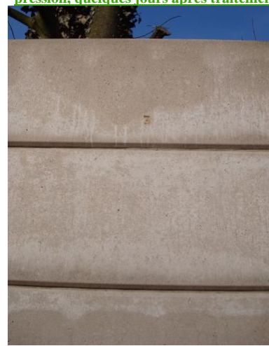
Aspect après un an, nettoyage eau haute pression, quelques jours après traitement
