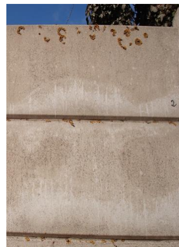
Aspect d'une palissade un an après traitement, nettoyage naturel, sans rinçage haute pression
